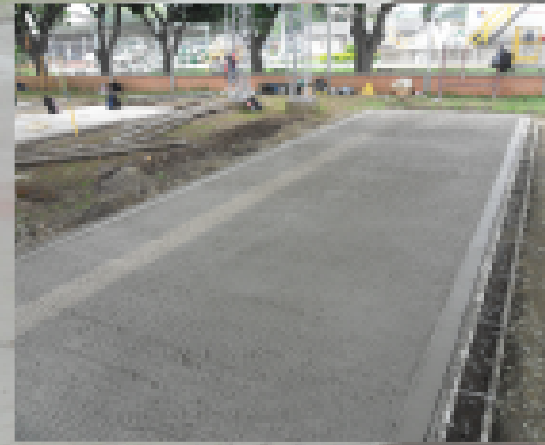
Base Aérea Cali (Hangares)
